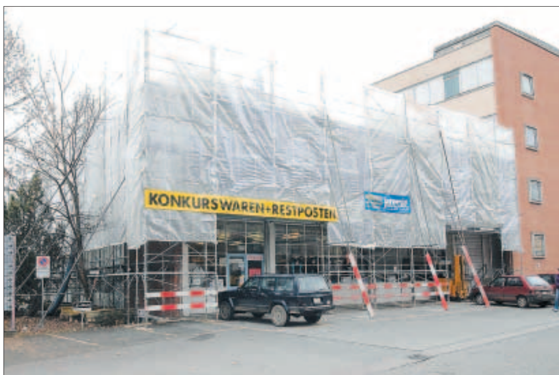
Hinter dem verhüllten Gebäude an der Seestrasse wird intensiv saniert und umgebaut. In die ehemalige Schlossbergschule ziehen im September 2004 die Elektriker ein. BILD PATRIC SPAHNI
